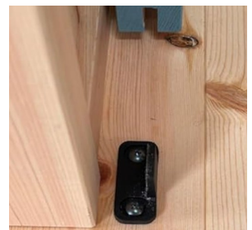
振れ止め施工イメージ
